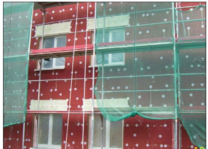
Fassade mit WDVS
